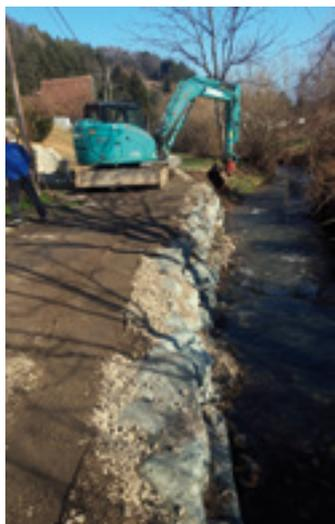
Aufgrund des Bachverlaufes und starker Regenfälle ist im Bereich der Bachstraße ein Teil der Böschung des Auebaches abgerutscht und es kam auch bereits zu Asphaltabrissen an der Fahrbahn.
